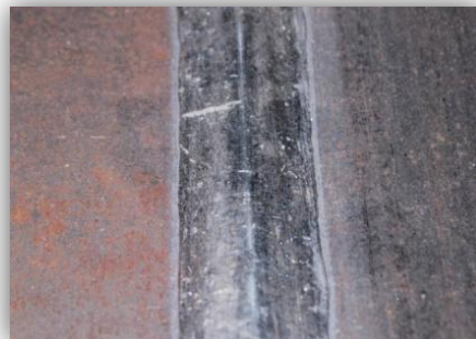
Многодуговая сварка продольных (заводских) швов труб (ОАО «ЧТПЗ», флюс ФСА ЧТ А 650-20/80)
