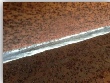
Сварка по ржавчине (флюс UF-03)
