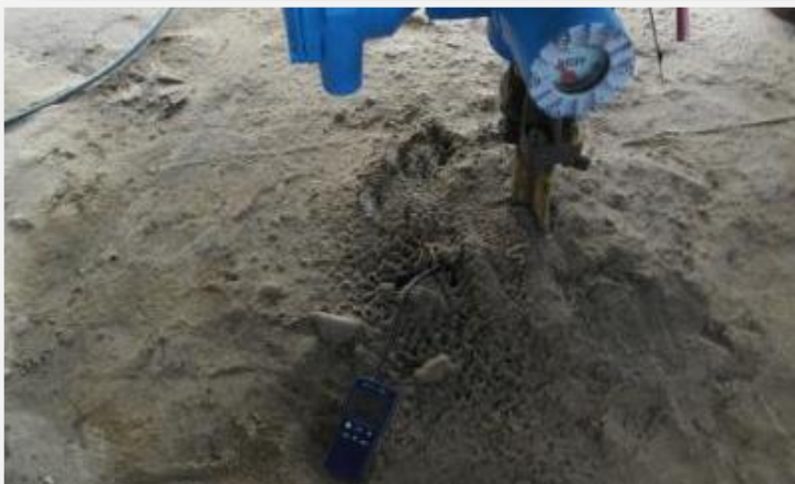
Негерметичность корпуса ТПА/ утечка по фланцам
