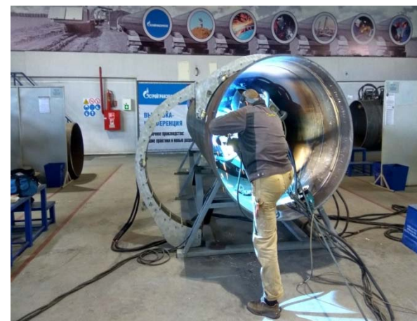
Подварка корневого слоя шва при имитации отказа сварочной головки
