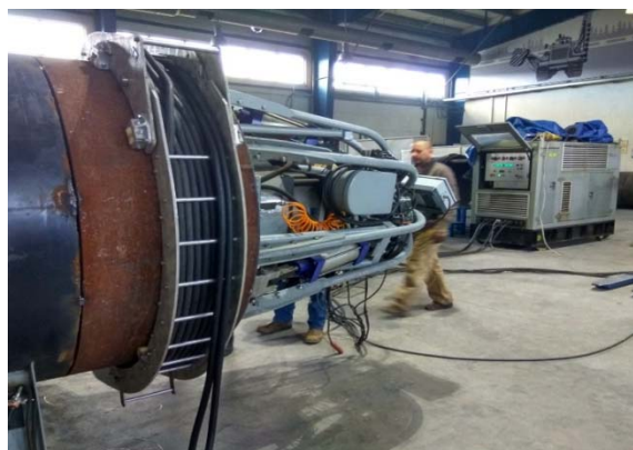
Подогрев КСС установкой индукционного нагрева марки ARGOHEAT-130
