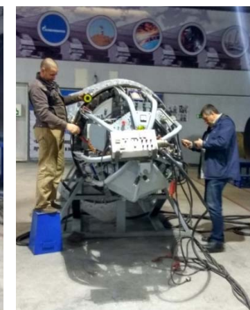
Замена проволоки на сварочных головках
