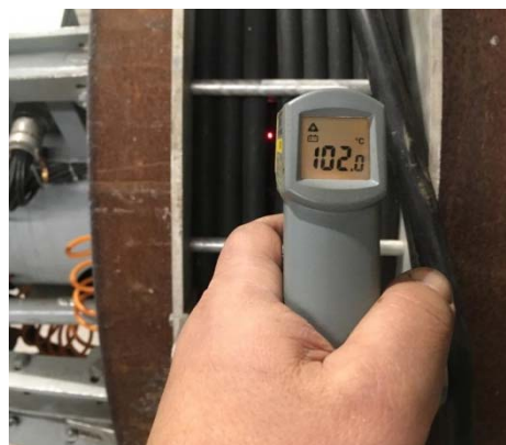
Контроль предварительного подогрева КСС (+100 +30 °C)
