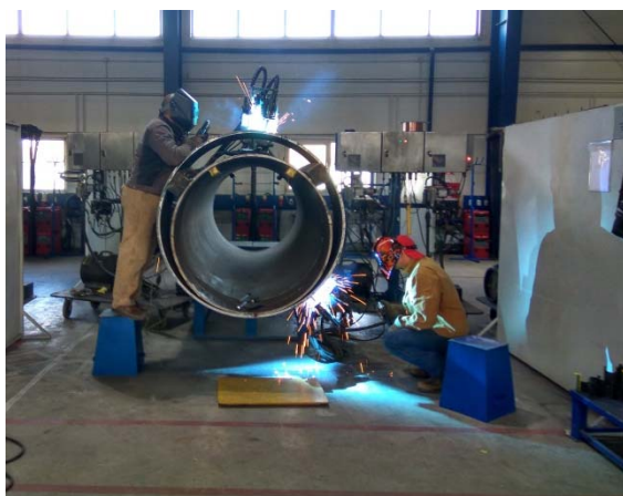
Сварка горячего прохода, заполняющих и облицовочных слоев шва сварочными головками Р-600 в защитной смеси 82%Ar/18%CO 2
