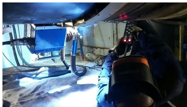
Автоматическая сварка в защитных газах заполняющего слоя шва
