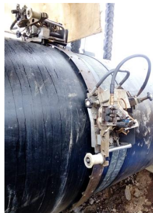
Внешний вид сборки под автоматическую одностороннюю сварку
