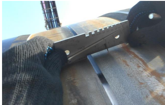
Внешний вид сборки под автоматическую двустороннюю сварку
