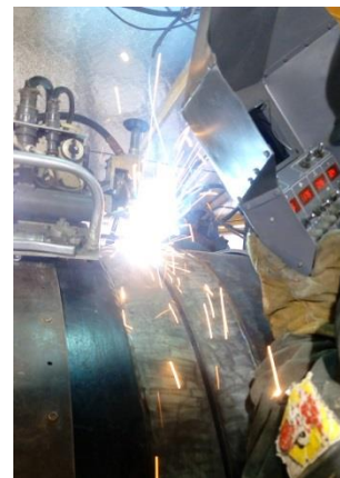
Автоматическая сварка в защитных газах заполняющего слоя шва
