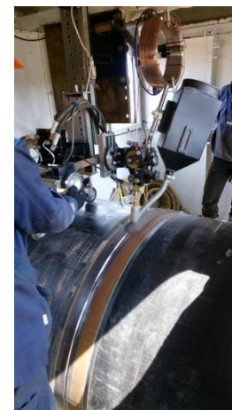
Внешний вид облицовочного слоя шва
