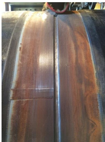
Автоматическая сварка под слоем флюса заполняющего слоя шва
