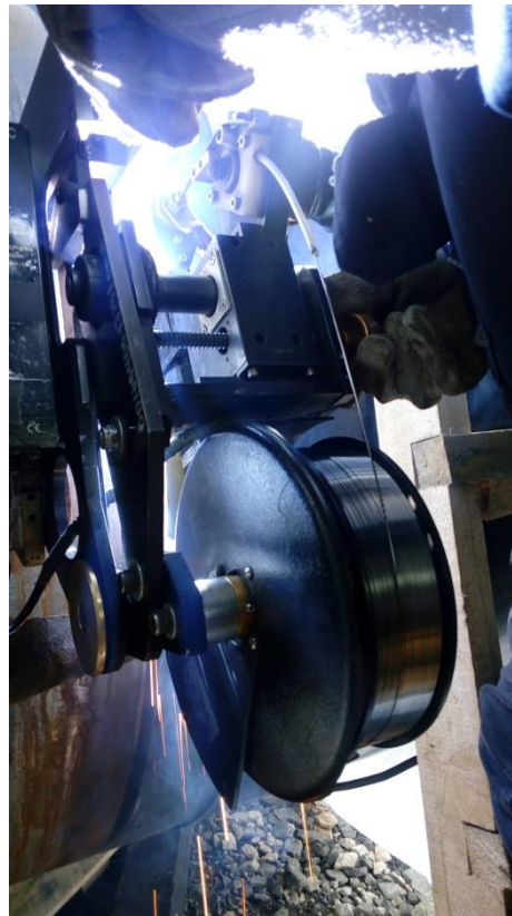
Сварка заполняющих слоев сварного шва
