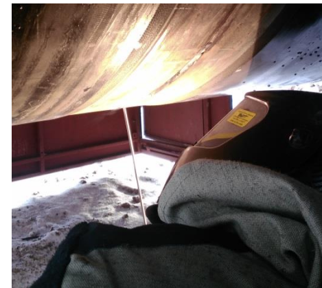
Ручная дуговая сварка заполняющего слоя шва
