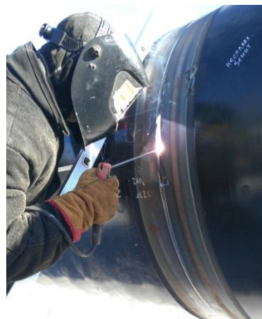
Сварка ремонтного шва
