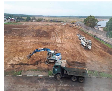
Сентябрь 2017. Начало строительства
