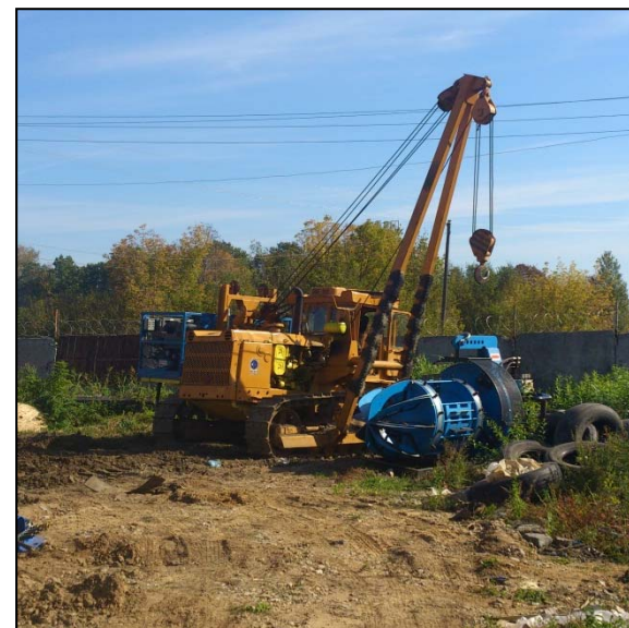
КТУ со смонтированной гидравлической станцией и СПК для трубы Ду = 1420 мм
