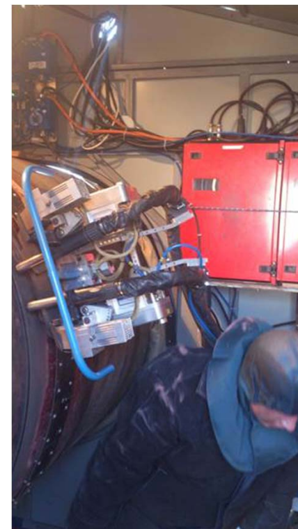
ГАС-2 на монтажном поясе после сварки прохода.
