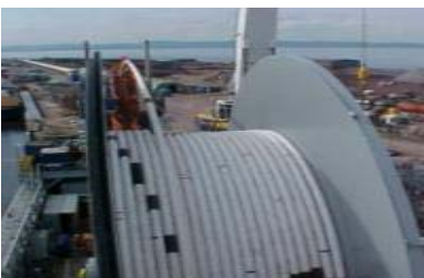
Береговая база сварки и непрерывного монтажа трубопроводов
