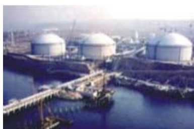
Резервуары и терминалы
