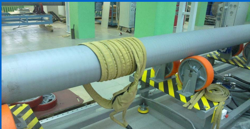
Нагрев перед нанесением покрытий на трубы D=90-330мм
