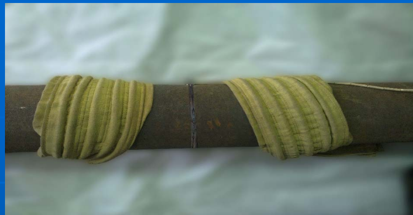
Нагрев перед сваркой и во время сварки труб D=90-330мм
