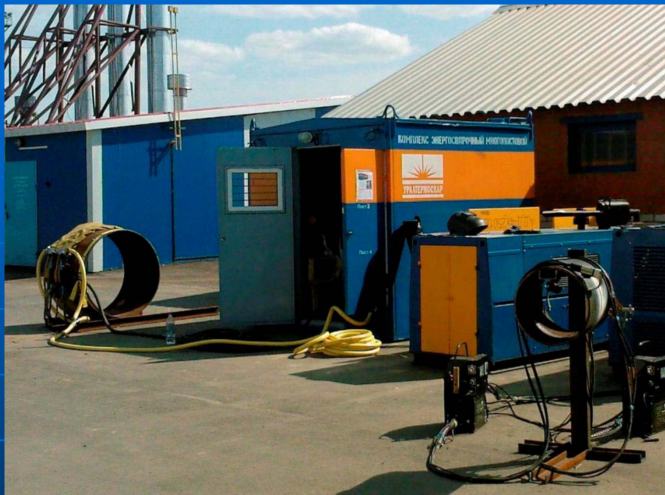
Индукционная установка для подогрева сварных стыков трубопроводов «ЭЛТЕРМ-С УИНТ-30-4» размещенная в комплексе КЭСМ-100-4-315
