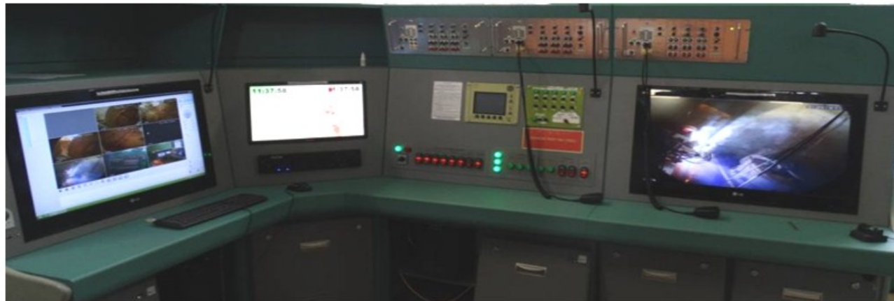
Вид пульта управления ГРК-30 с 9 видеокамерами непрерывной видеозаписи рабочего процесса
