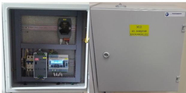
Шкаф УСО электроэнергии в здании ЗРУ-10 кВ
