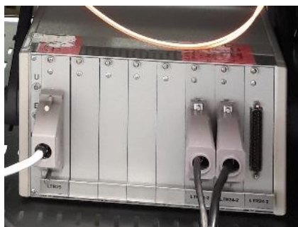
Шкаф УСО электроэнергии в здании ЗРУ-10 кВ
