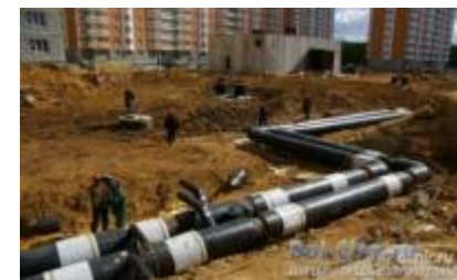
Строительство и ремонт трубопроводов бытового назначения
