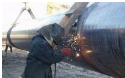
Сварка трубопроводов
