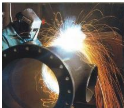
Сварка сосудов, работающих под давлением
