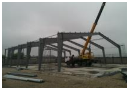
Монтажная сварка ответственных металлоконструкций
