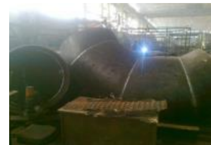
Изготовление трубных деталей
