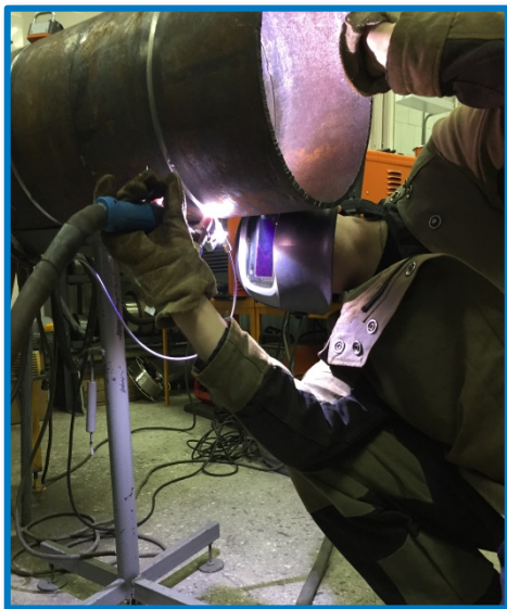
Механизированная аргодуговая сварка корневого слоя шва
