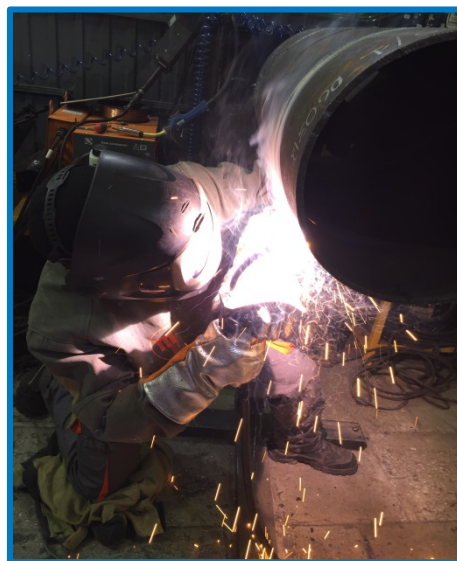
Механизированная сварка самозащитной порошковой проволокой заполняющих и облицовочного слоёв шва
