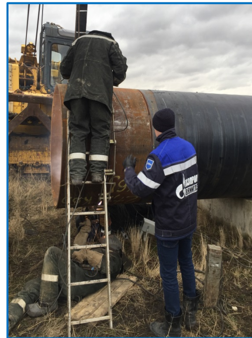
Сварка допускного стыка перед полигонными испытаниями (08.11.2018)
