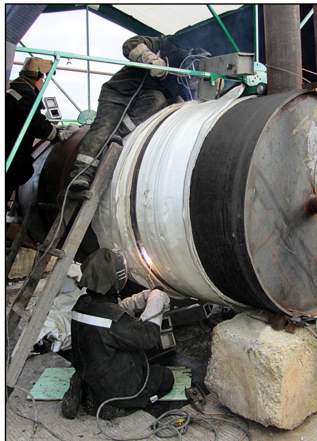
Сварка кольцевых нахлесточных швов на стенде DN 1400
