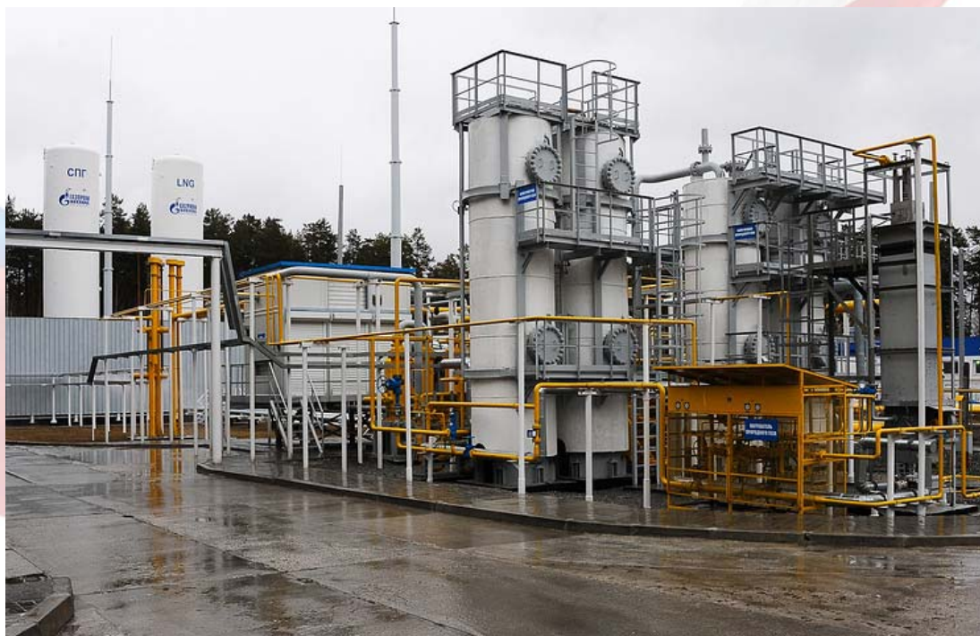
Десятки тысяч сварных соединений на одном объекте
