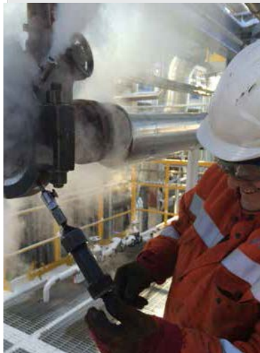
Безостановочные методы ремонта
